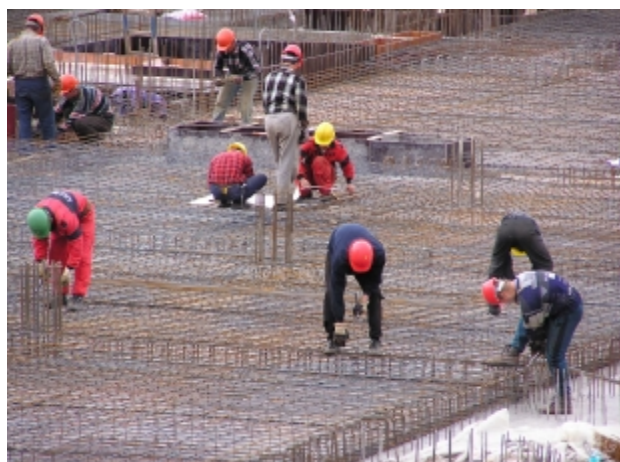
práce na výztuži stropní desky
