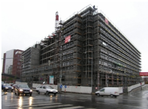
nosná konstrukce budovy ve výstavbě
