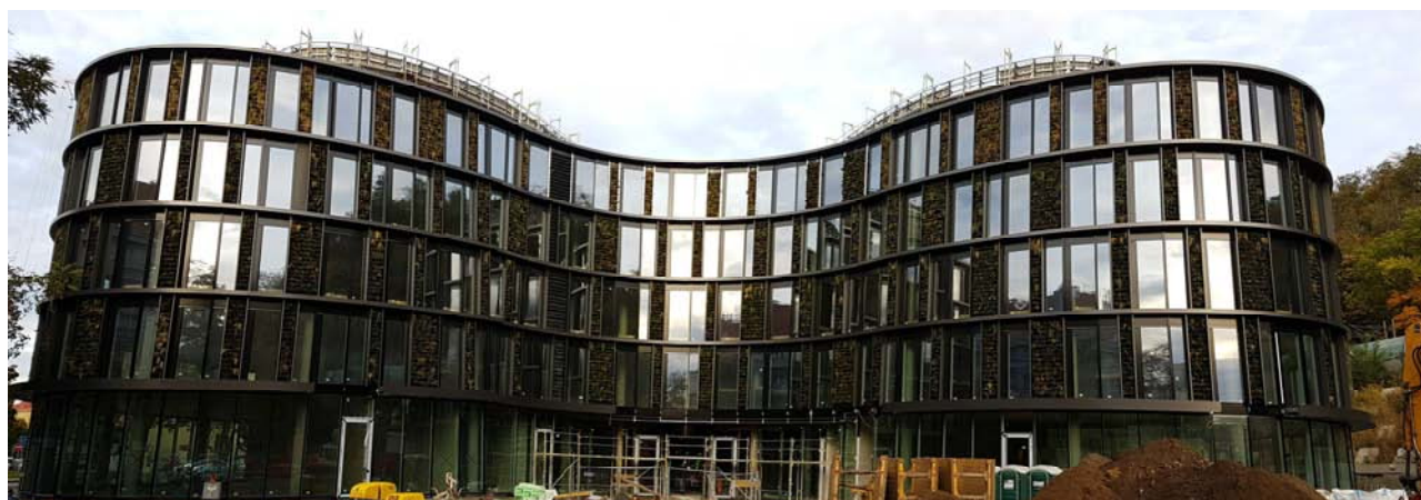
fotografie z průběhu stavby
