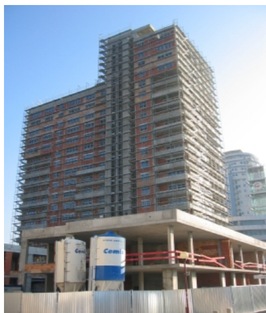
dokončení hrubé stavby
